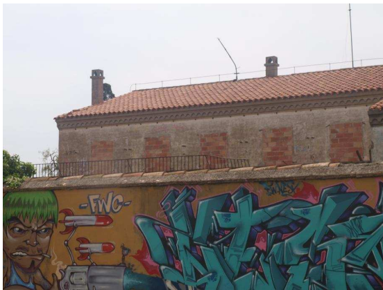
Detalle parte posterior de uno de los edificios
