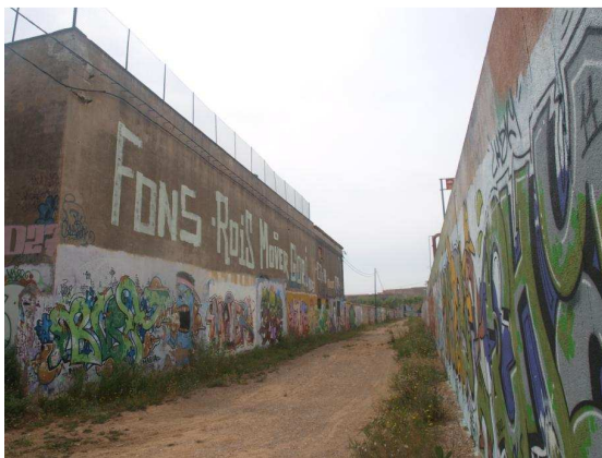
A la izquierda lateral de la propiedad. Derecha antigua DAKSA Vista desde parte posterior.
