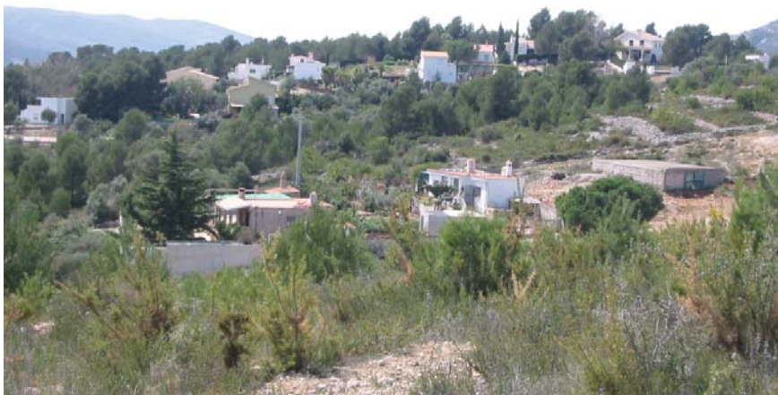
Escaso desarrollo de la Urbanización Vista Bella
