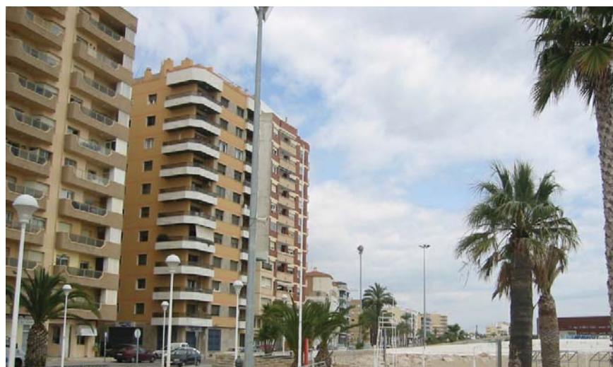
Viviendas colectivas. Playa Morrongo. Avda Marqués de Benicarló
