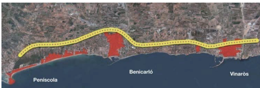
Circunvalación de la CN-340 a su paso por Vinaròs y Benicarló que permitirá la desafección de la carretera a su paso por estas ciudades y su conversión en bulvar metropolitano.
