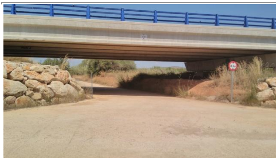
Tramo en el cruce con variante de la N-340
