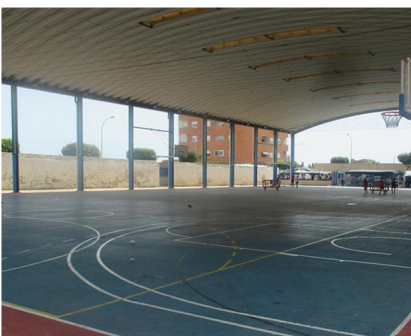
Pista exterior del Pavelló Poliesportiu
