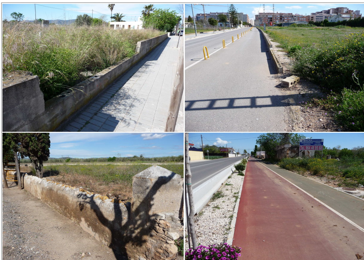
▲▲ Muros delimitadores vial - suelo rústico, de escasa resistencia, deficiente fijación al terreno y acabados a obra vista. ▲◀ Muro delimitador de tipología tradicional. ▲▶ Delimitación de borde y de usos en vial de construcción reciente.
