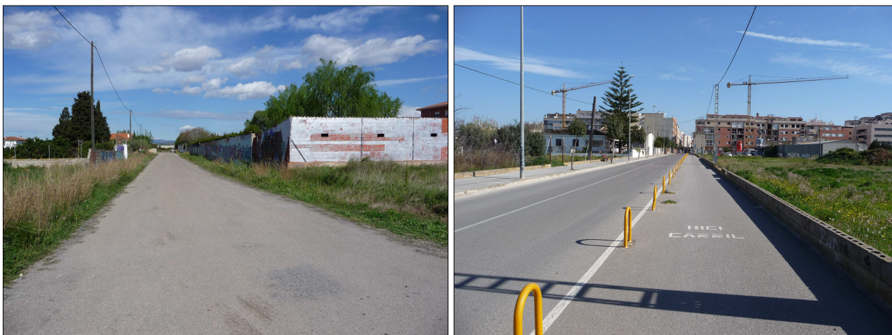
Cerramientos y muros delimitadores a obra vista existentes en el área de actuación
